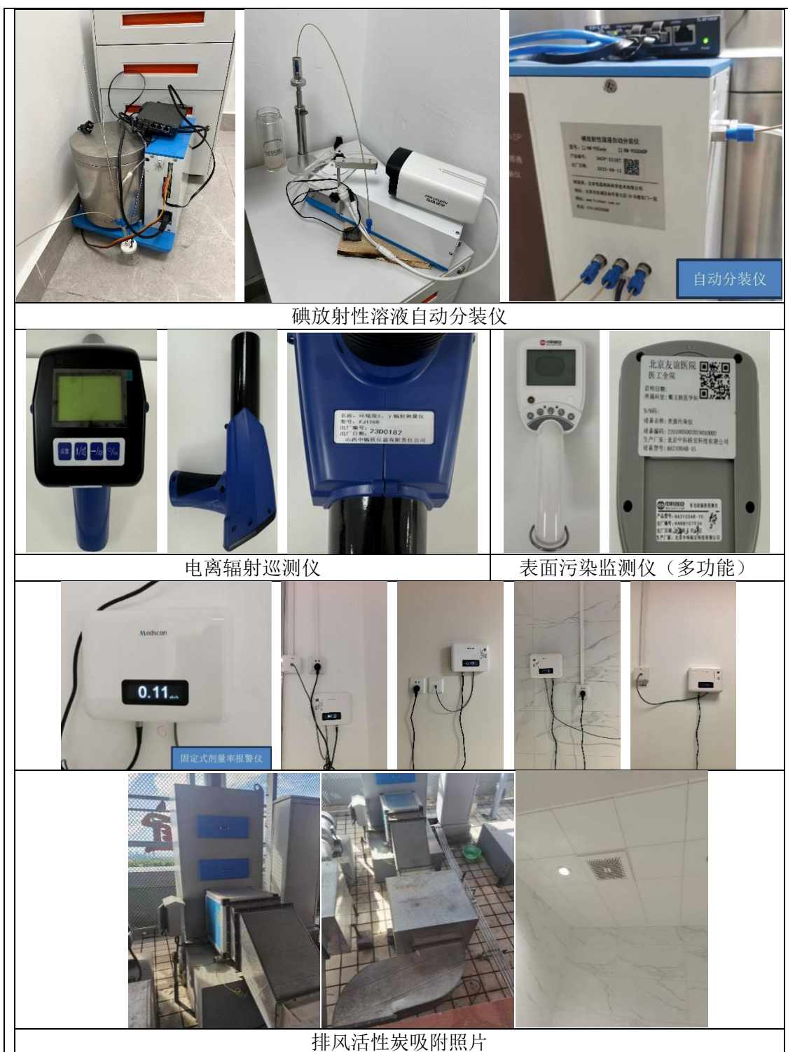
图 3-2 顺义院区核医学科治疗区（含病房）配备的防护措施现场照片
